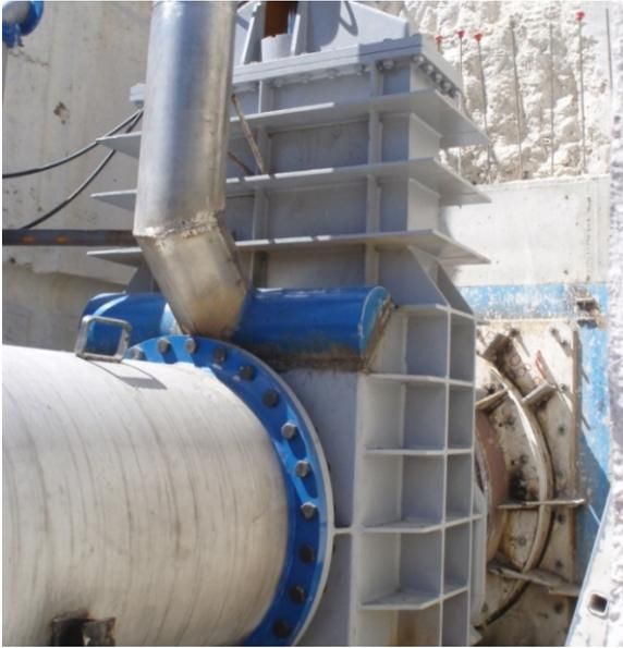
OBRAS DE EMERGENCIA PARA LA INSTALACIÓN DE UNA TOMA INTERMEDIA EN LA PRESA DE OLIANA (LÉRIDA)
